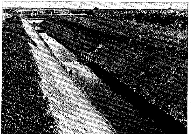
Abb. 7 Ausbau eines größeren Vorfluters mit Bongossi-Streifen zur Böschungssicherung (bei Nissenhörn, nördl. von Bredstedt, Juli 1974)
