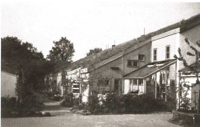
Dachbegrünung in Hannover-Bothfeld
