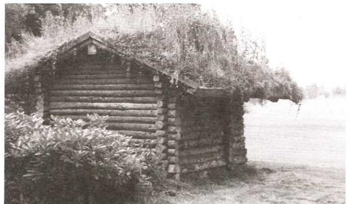
Abb. 6: Durch Sturmschäden anfallendes Nadelholz konnte in dieser Wetterhütte verbaut werden.
