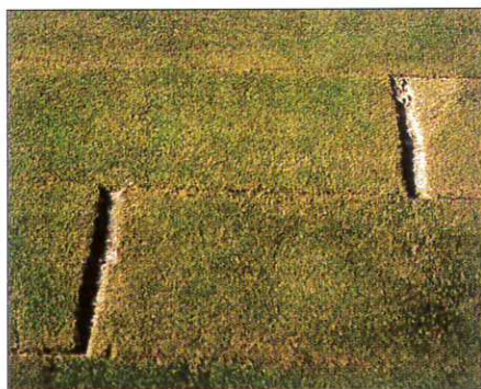
Ungenaueres Verlegen führt zu Lücken an den Sodenrändern.
