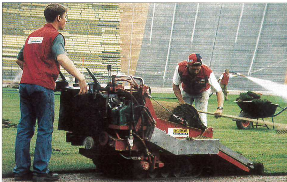
Verlegen des Fertigrasens mit Spezialgerät für Großrollen auf Tragschichtoberfläche mit Wurzelaktivator Agrosil.
