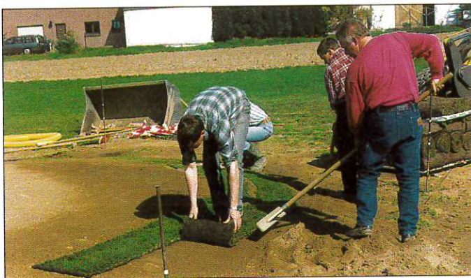
Verlegen von Fertigrasen im Randbereich
