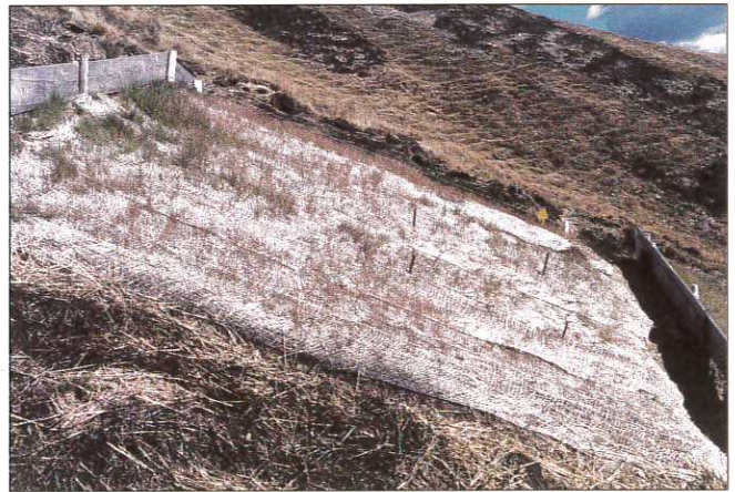
Abb. 9: Die Jutenetz-Strohdecksaat nach zwei Vegetationsperioden. Das weitmaschigere Jutenetz ermöglichte ein besseres Pflanzenwachstum und eine gleichmäßigere Pflanzenverteilung als das Kokosnetz. Pfannhorn/Südtirol, 29.9.1997.
