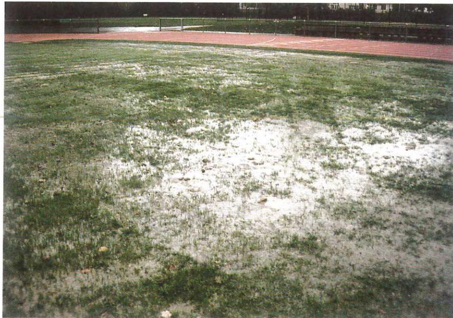
Abb. 1: Stadionrasen unbespielbar wegen zu geringer Wasserdurchlässigkeit, aufgrund falscher Zusammensetzung der Rasentragschicht (Foto: Armbruster)
