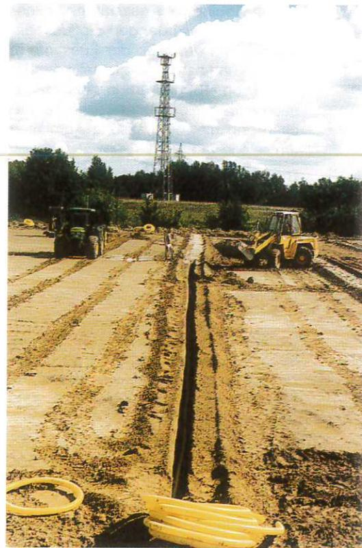
Bei der Herstellung der Rasentragschicht kommt es auf das richtige Mischungsverhältnis der Baustoffe an
