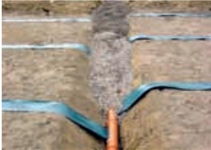
Abbildung 2: Das Drain Belt®-System der Versuchsanlage während des Baus
