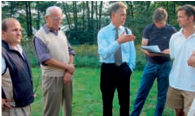
Horst Schubert (Mitte) erläutert die Wasseraufbereitungsanlage am Seddiner See.
