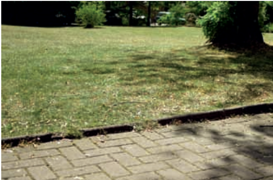
Abbildung 2: Übergänge zwischen Rasen und befestigten Flächen, die nicht höhengleich ausgeführt werden, führen zu einem erheblich erhöhtem Pflegeaufwand.
