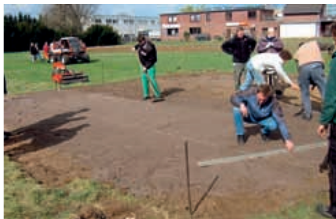
Ein Highlight in der Lehrgangspraxis war die Erstellung einer Rasenfläche vom Einbau der Rasentragschicht bis zur professionellen Einsaat.
