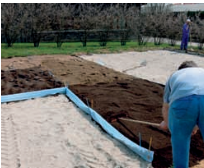
Abb. 6: Einbau der Substrate mit Abgrenzungen aus PE-Folie (Foto: Henle)
