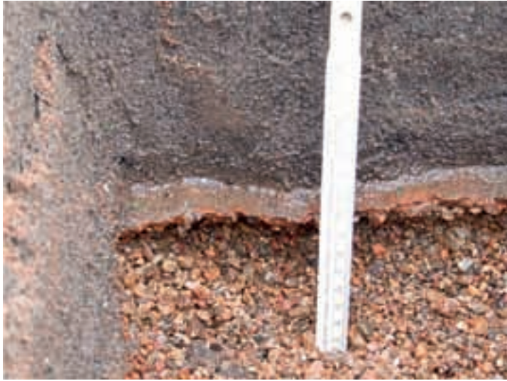
Abb. 4: Wasseraustritt auf der Kolmationsschicht; sie wirkt als Sperrhorizont
