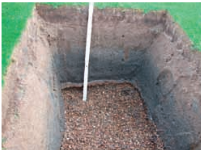
Abb. 2: Profilansicht des Grünsaufbaus
