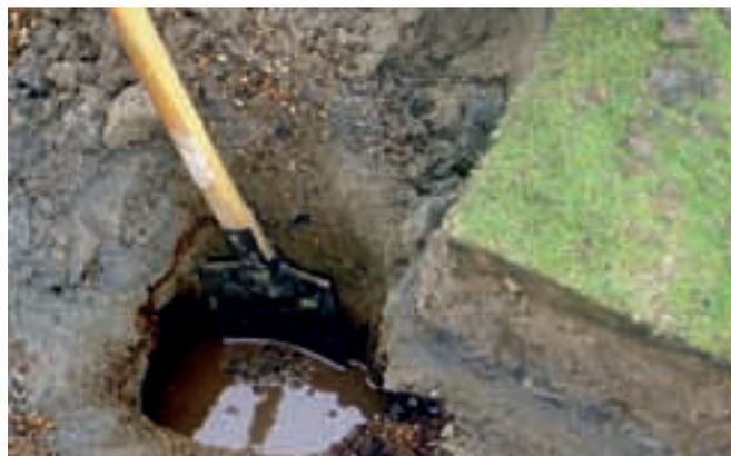
**Abbildung 5: Draingraben mit stehendem Wasser im Schad- stellenbereich**
