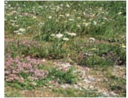
Abbildung 4: Schotterrasen als wasserdurchlässige und begrünbare Alternative zu asphaltierten PKW-Parkplätzen nach 3 Jahren auf der Donauinsel Wien (2004): 3-5 mal jährlich gemäht (Schnitthöhe 4 cm), in Trockenperioden bewässert und 2 x wöchentlich mit PKW befahren
