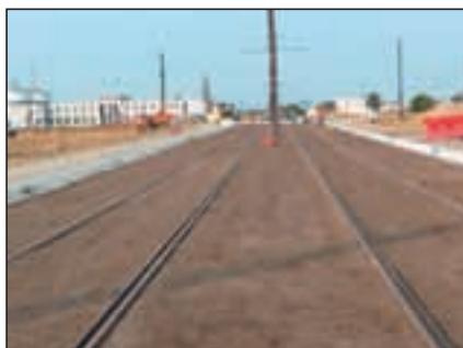
Abb. 8: Vorbereitung des Gleiskörpers mit Rasentragschicht zur Begrünung der neuen Tramway in Angers mit 56.000 m 2 Fertiggras. http://tramway.angersloiremetropole.fr
