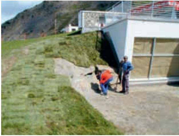
Abb. 3: Alpine Rollsoden garantieren auch in extremen Hochlagen sofortigen Erosionsschutz nach kleinflächigen Eingriffen (Ischgl, Tirol, 2.400 m ü. NN).
