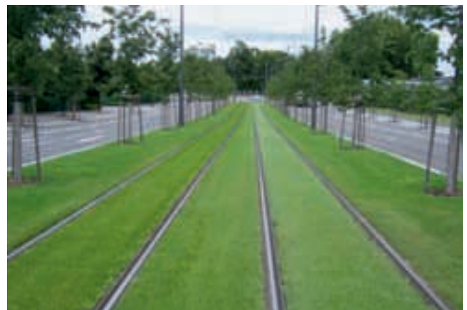
Abb. 9: Bei guter Ausführung gleicht die Gleis-Begrünung einem „grünen Teppich“ (Bild: Besier, 2010).
