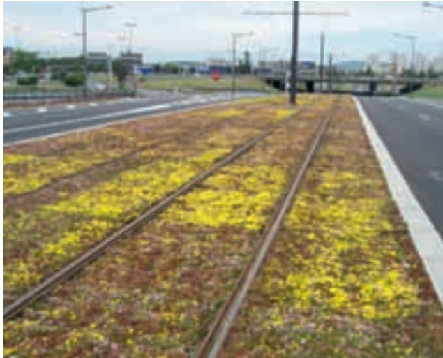
Abb. 10: Sedumgleise wirken oftmals als technische Begrünung und erscheinen im Stadtbild daher oft als Unnatürlich (Bild: Besier, 2010).
