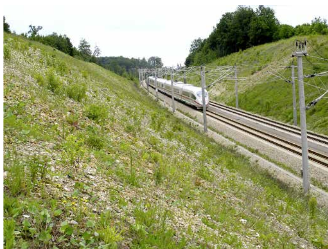
Abb. 1: Böschungen an der ICE-Neubaustrecke Nürnberg-Ingolstadt, mit Ansaatbegrünung (rechts vorne) und Selbstbegrünung auf skelettreichem Untergrund (links).
