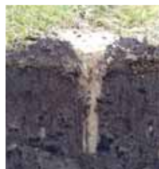
Abb. 4: Drän Schlitz-Raster: Schlitztiefe: max. 15 cm / Schlitzbreite bis 3 cm (Profilsicht).
