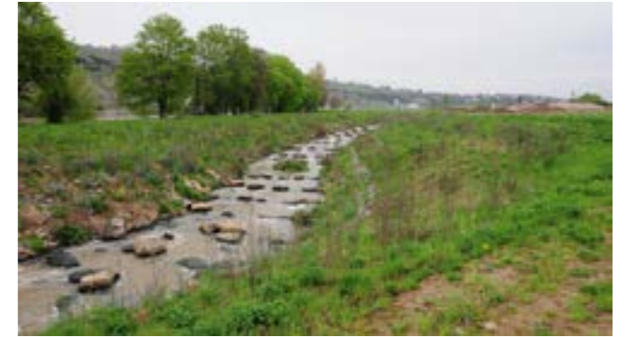
Abb. 4: Neu angelegter Bachlauf als „Umgehungsgerinne“ für den Fischeaufstieg an der Neckar-Staustufe Poppenweiler. Foto: M. Sax
