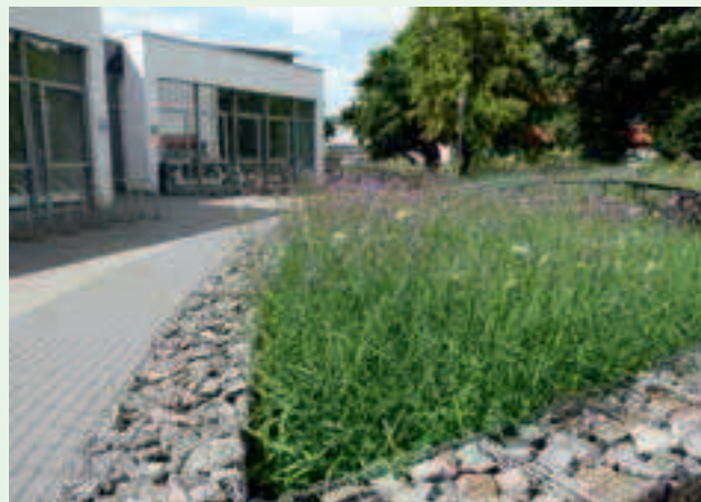
Hörsaalgebäude an der Hochschule Osnabrück.
