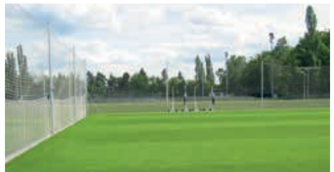
Abb. 1: Gut gepflegte und gewartete Sportanlagen haben in der Regel keine Sicherheitsprobleme.
