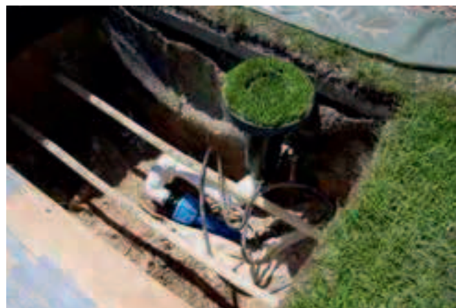
Die modernen Toro-Getrieberegner mit Gummilippe und Kunstrasen-Abdeckung. Foto: Toro
