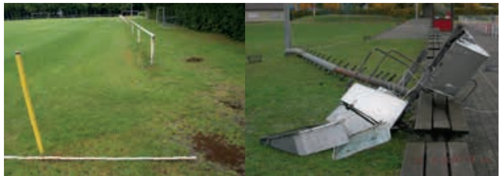
Abb. 4: links: Unzureichende Sicherheitsabstände können zu Verletzungen führen, für die unter Umständen der Betreiber verantwortlich gemacht werden kann. Rechts: Nächtlicher Mastumbruch. Schadenstelle: erster Absatz auf ca. 4 m Höhe System: Stahlmast verzinkt, abgesetzt, ca. 30 Jahre alt, Lichtpunkthöhe: 18,50 m. (Foto: Roch, Lübeck)
