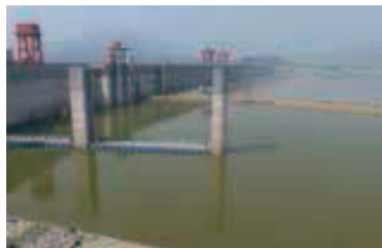
Abb. 3: Noch bleiben 30 Meter Fassungsvermögen bei der 185 Meter hohen und 2,34 km langen Staumauer, die an der Basis 130 und an der Krone 18 Meter Stärke aufweist.
