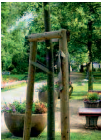
Abb. 16: Diese Baumanbindung sollte umgehend erneuert werden.
