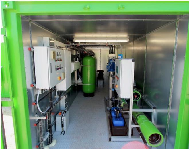
**Innenansicht Container mit Umkehrosmoseanlage.**
