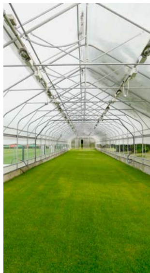
Abb. 12: Sodengarten im beleuchtungsfähigen Klimatunnel
