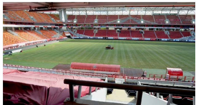
Abb. 9: Die Teilnehmer konnten die Renovations-Maßnahmen verfolgen
