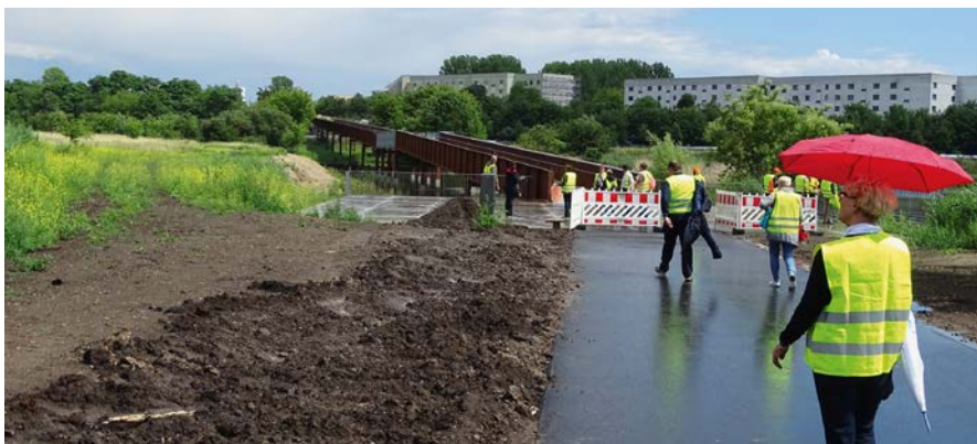
Abb. 6: Rundgang im Gelände mit Blick auf den 280 Meter langen Wuhlesteg. (Foto: K.G. Müller-Beck)
