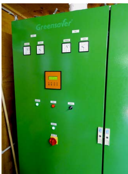
Abb. 2a+b: Greensaver-Anlage zur Behandlung des eingesetzten Brauchwassers.
