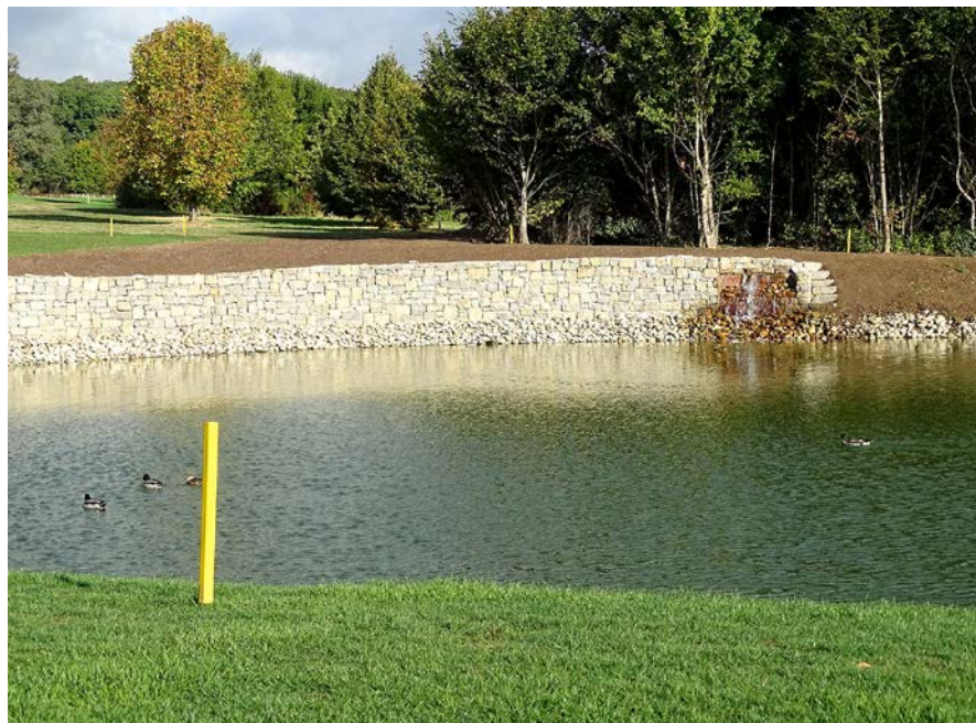
Abb. 1: Erweiterter Beregnungs-Teich mit massiver Steinmauer und Wasserzufluss bis 10.000 m 3 . (Alle Fotos: K.G. Müller-Beck)
