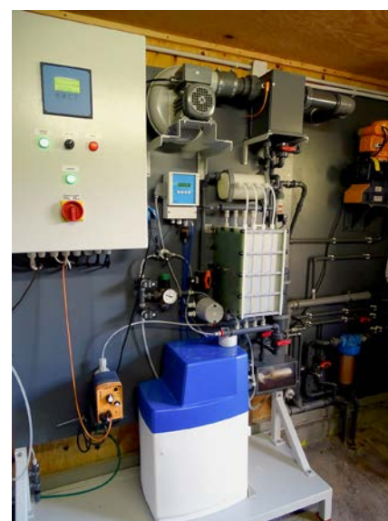
Abb. 2a+b: Greensaver-Anlage zur Behandlung des eingesetzten Brauchwassers.
