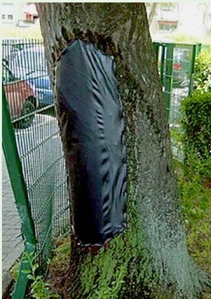
Abb. 27: Nach Entfernung der losen Borke wurde die frische Wunde mit Folie überdeckt um in der feuchten Atmosphäre die Entwicklung eines Flächenkallus zu begünstigen.
