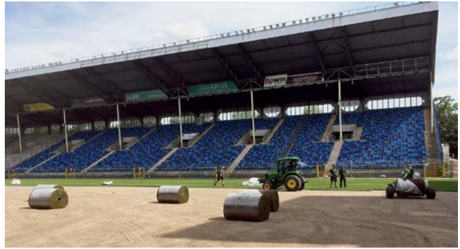
In nur acht Wochen wurde die Rasenfläche saniert und die Regenwassernutzungsanlage installiert. (Foto: Stadt Mannheim)
