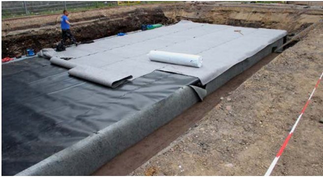
In einem dritten Arbeitsschritt wurde die Rigole nochmals mit dem Geotextil umschlossen.
